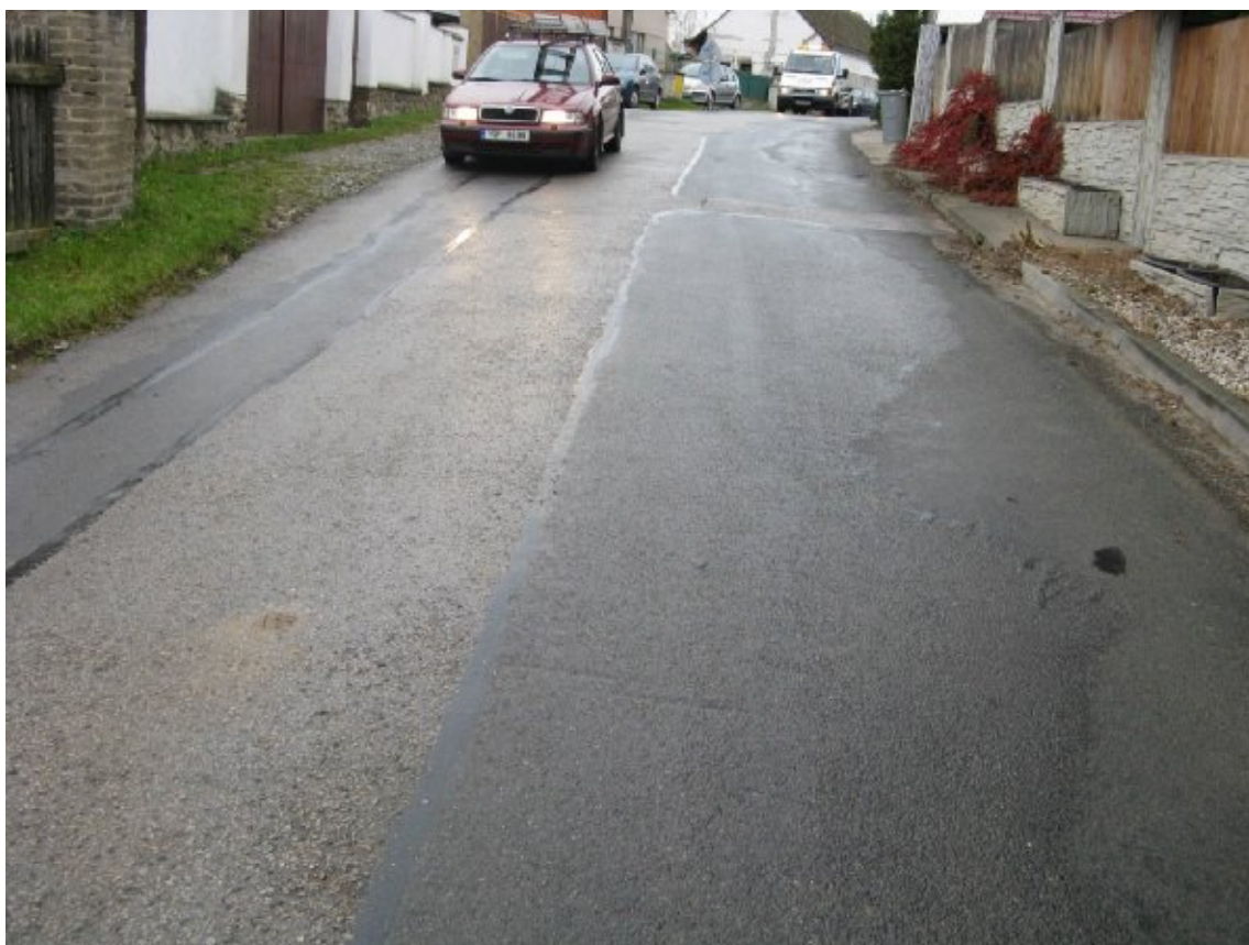
F06, km 0,510+ Zapravené rýhy a překopy, vysprávkky, nepravidelné hrboly, poklesy a deformace.
