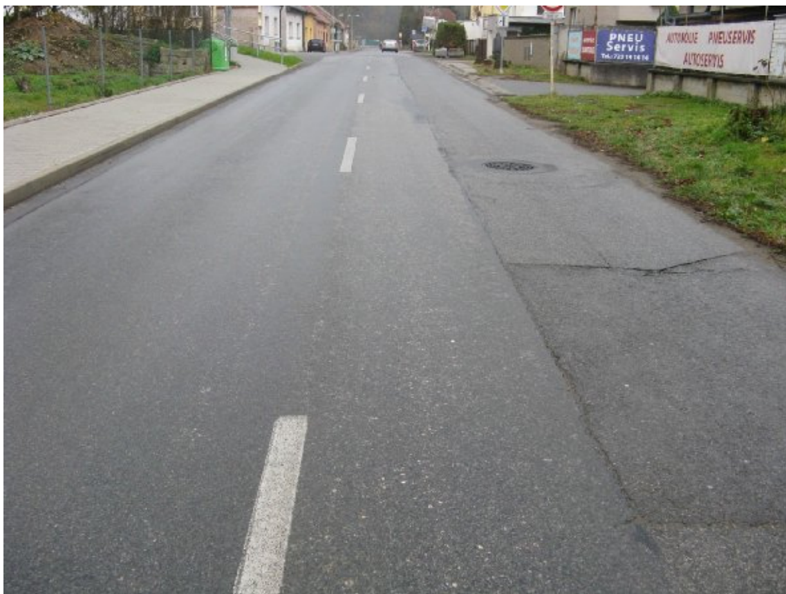
F15, km 21,710+ Vpravo zapravená rýha s mozaikovými, příčnými a nepravidelnými trhlínami.
