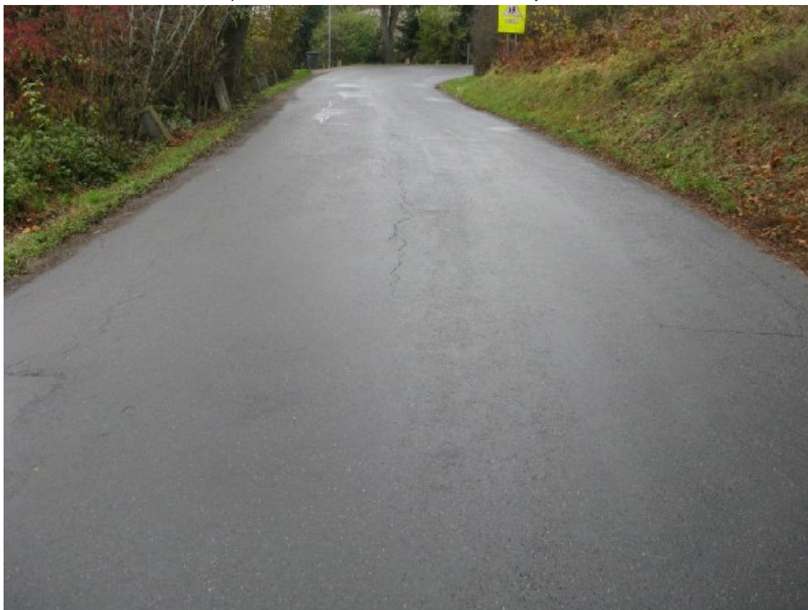
F02, km 0,120+ Mozaikové, příčné, podélné a nepravidelné rozvětvené trhliny.
